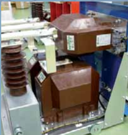
› UCL-7 Compartimento de transformadores de tensión en celda de media tensión.
