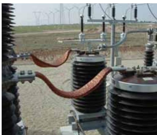
› Transformadores de intensidad (CX) de 72,5 kV dedicados a la protección de una subestación eólica. Iberdrola (España).
