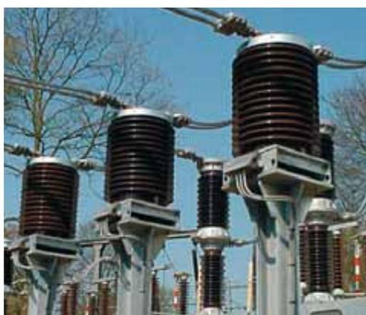
› Transformador de intensidad de 72,5 kV (CX). Yuandon Textil Co. (Taiwan).
